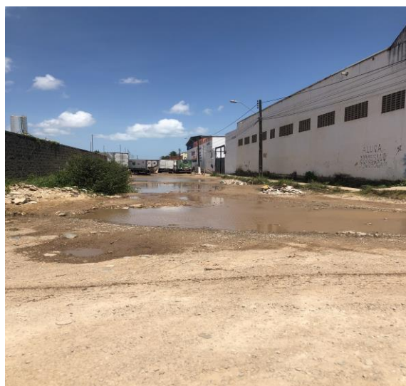
Figura 04 - Pontos de alagamentos da Rua Cap. Gutemberg (Fonte: SEINF, Novembro/19)
